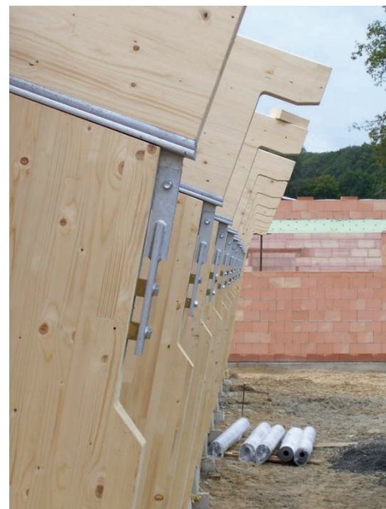
Stütze mit Ausfräsungen für nachträgliche Blenden
