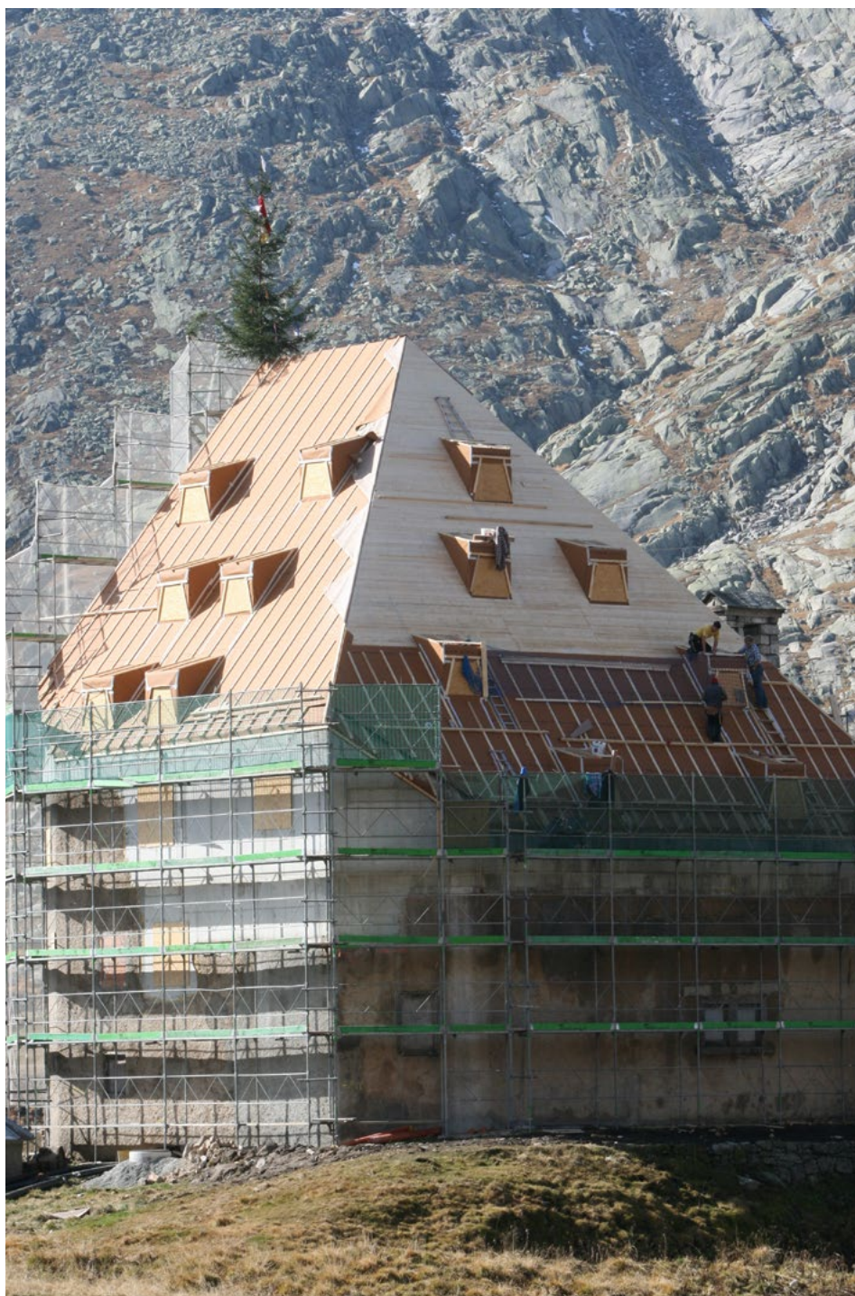
Sankt-Gotthard-Hospiz auf 2.091 m Höhe: Extremes Außenklima, realisiert mit Stamisol DW Dachunterspannbahn, funktionssicher auch nach einem Winter mit freier Bewitterung der Dachunterspannbahn
