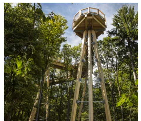
28 dreibeinige Stützelemente mit Höhen von 7 m bis 24 m wurden für den Rundweg von Schaffitzel Holzindustrie produziert und montiert.
