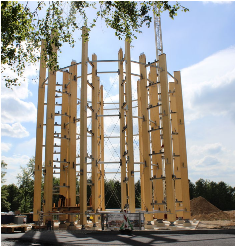
Der Aussichtsturm ist 40 m hoch. Sein Durchmesser verjüngt sich von 18 auf 12 m, wobei dieser mit 24 Stützen mit Höhen von 21 bis 40 m abgestützt wird.
