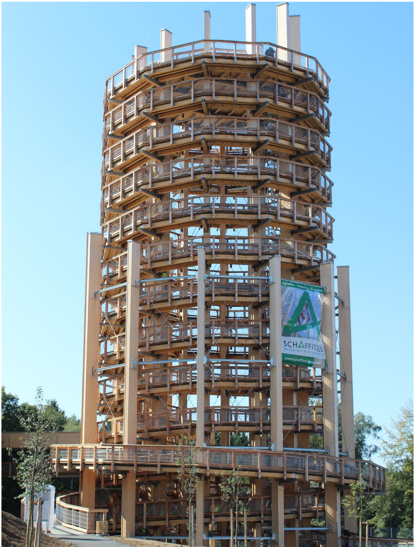
Allein der Turm besteht aus 167 Turmaufstiegs-elementen, die im Werk der Schaffitzel Holzindustrie vorgefertigt wurden.
